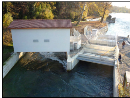
Villa d'Alme HPP
