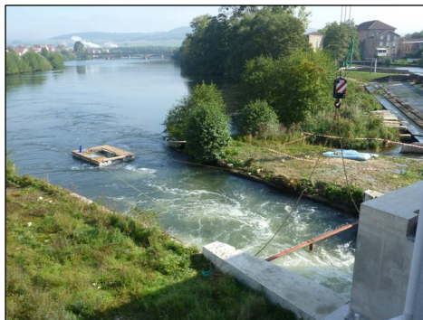
Installation du dispositif de récupération cadre de filet, filet et ponton flottant
