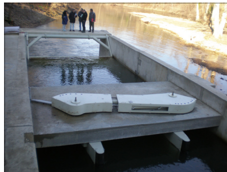
Saint Jean de Rives après rénovation
