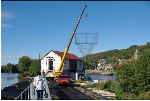
Vue Générale de la PCH de Frouard
