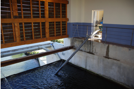
VLH en eau dispositif d'injection en place
