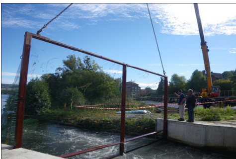
Mise en place du filet à la grue
