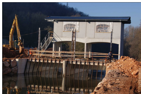
Centrale de Terrasson
