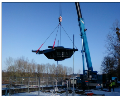
Mise en place de la VLH de l'Ame en janvier 2010
