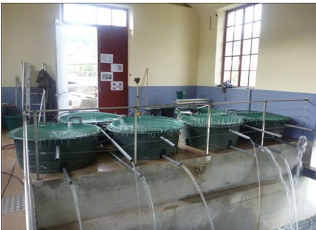
Bacs de stockage avec trop pleins
