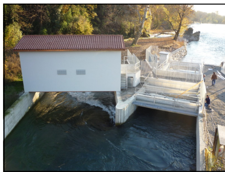
Centrale Hydroélectrique de Villa d'Alme
