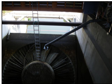
Installation du dispositif d'injection des anguilles
