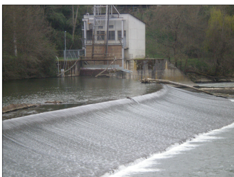
Saint Jean de Rives avant rénovation
