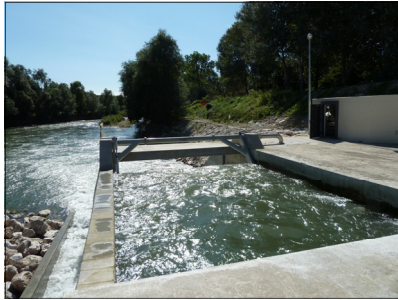
Centrale de Montodine au sud de Milan une VLH DN 4500 de 500 kW
