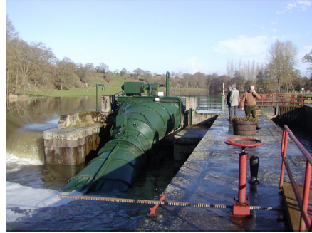
Installation existante typique de la Mayenne
