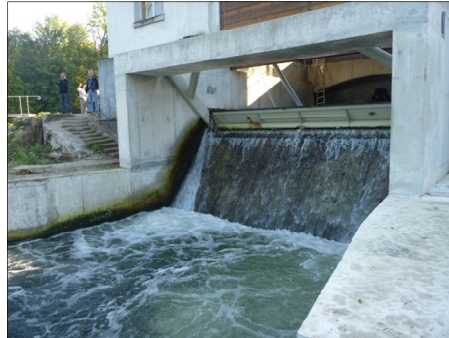
Vue Aval de la restitution de la centrale de Frouard
