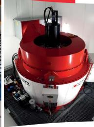
La centrale de Couzon au Mont d'Or, dernière centrale sur la Saône avant sa confluence avec le Rhône, est située au droit d'un barrage VNF. Elle est équipée de 2 turbines siphon simple réglage, de diamètre 3,90m et disposait de 2 multiplicateurs et génératrices asynchrones à 1000 tr/min. MJ2 Technologies s'est vu confier le projet de rénovation profonde de la Centrale.
