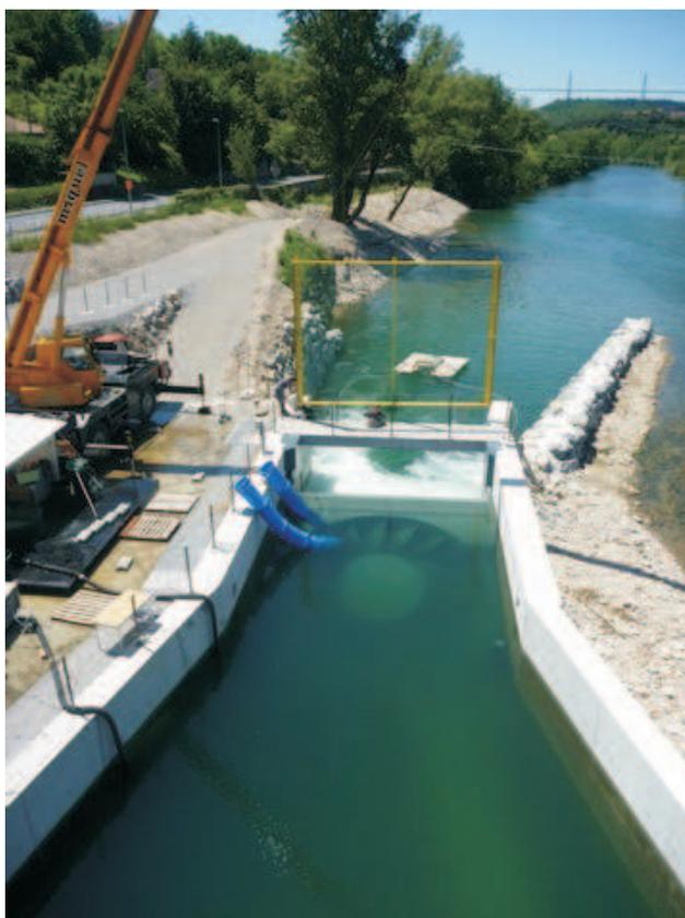
Vue de la VLH, des tubes d'injection et du cadre supportant le filet de récupération des poissons.
