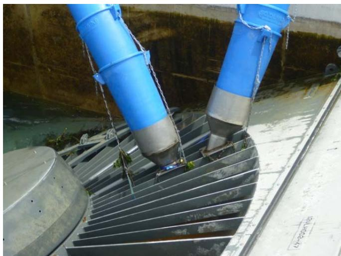
Sortie des tubes d'injection entre les barreaux à mi-pale et à l'extérieur
