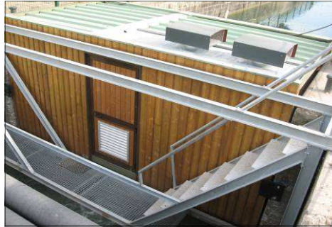
Vista posterior del local técnico y la pasarela de acceso
