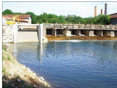
Central Hidroeléctrica de Clairvaux
