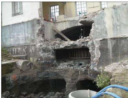
Demoliciones aguas abajo
