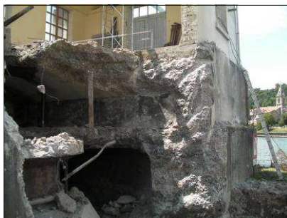
Demoliciones aguas abajo
