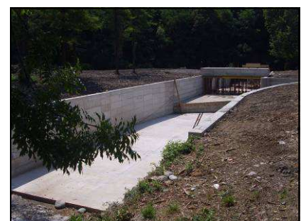
Toma de agua en derivación del canal de restitución de la central de Vila d'Alme
