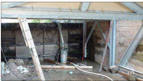
Estructura de soporte de la VLH y del edificio de los equipos técnicos.
