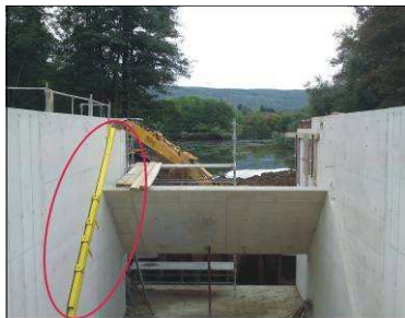
Colocación de las piezas a encofrar mediante herramientas de posicionamiento de MJ2
