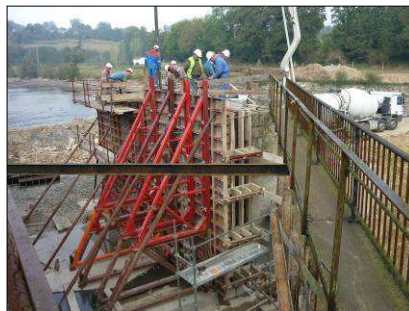
Obra de la central de l'Ame
