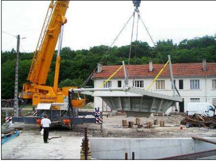
Montaje de la VLH en su ubicación
