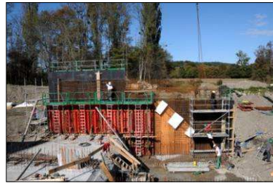
Obra de la central de Les Barrets
