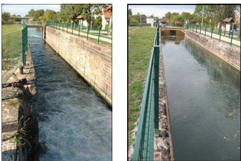
Antes y después de la instalación de la VLH
