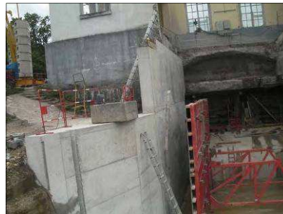
Desencofrado del muro derecho
