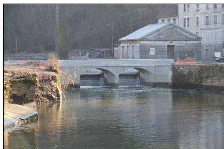
Elektrownia wodna w Fraisans z nowym mostem widok z dołu
