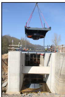
Projekt w Mayenne: etap podnoszenia pierwszej turbiny VLH za pomocą dźwigu
