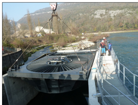
Zakończenie montażu turbiny VLH w miejscu docelowym
