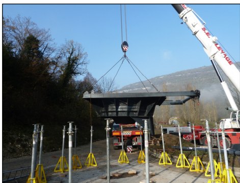
Montaż zespołu ważącego 48 ton przy użyciu dźwigu
