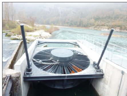
Turbina w pozycji uniesionej - widok z góry
