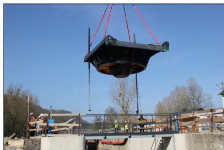
Montaż turbiny VLH na rzece Mayenne
