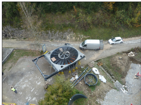
Montaż turbiny VLH DN 5000
