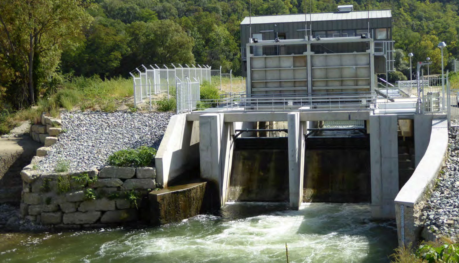
Photo : Cavaletade aval
