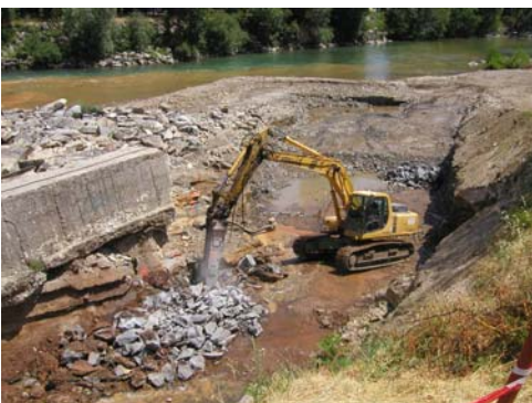
Excavation aval au niveau de l'implantation de la VLH
