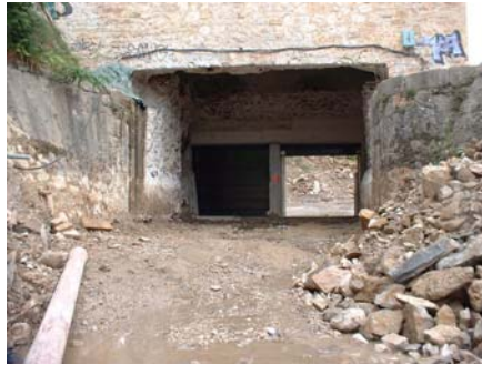
Passage d'eau complètement dégagé sous l'ancien bâtiment
