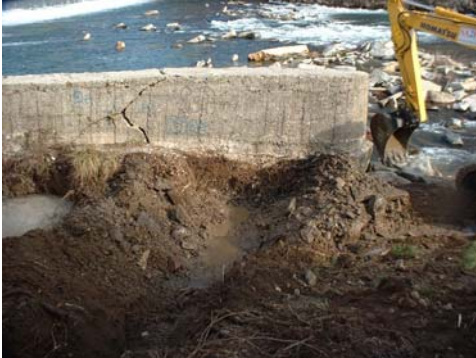
Nettoyage et sondage à l'aval du moulin au niveau de l'implantation de la VLH
