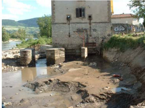
Le chantier est hors d'eau. Les excavation peuvent commencer
