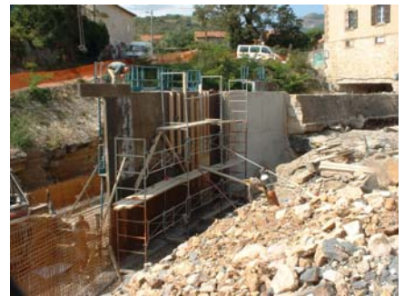
Coffrage des bajoyers au niveau de l'implantation du groupe VLH
