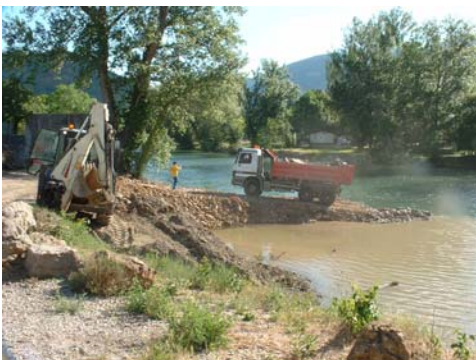
Construction du batardeau amont
