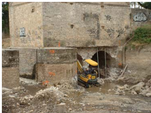
Les excavations sont terminées, les démolitions en sous œuvre commencent à l'amont
