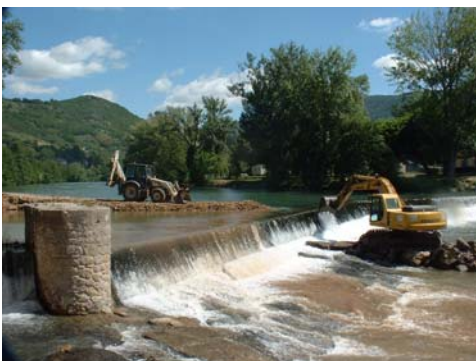
Les batardeaux amont et aval se rejoignent presque
