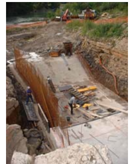
Ferrillages latéraux au niveau du bloc VLH
