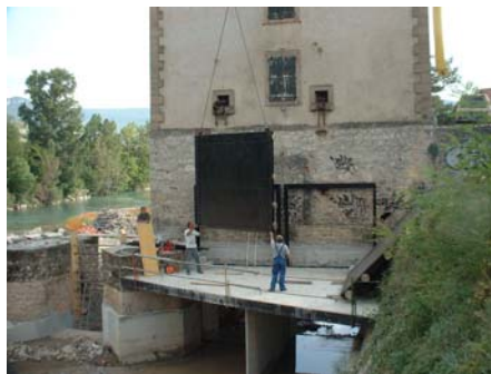
Mise en place des tabliers des vannes amont
