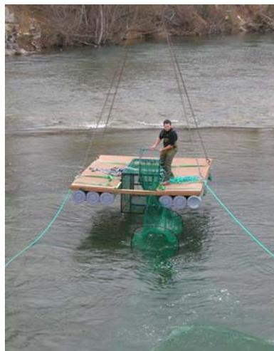
Mise en place du dispositif de récupération des anguilles en aval de la turbine
