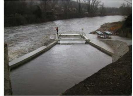
Le Tarn en crue le 22/11/07, la chute est réduite de moitié, la VLH produit toujours plus de 220 kW
