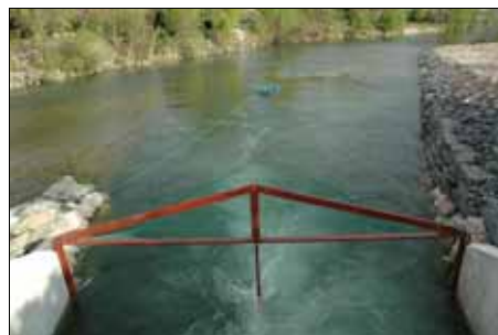
Dispositif de récupération complet en eau
