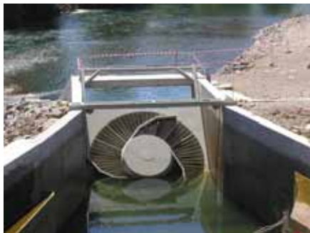
La VLH de Millau en position de travail
