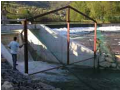
Mise en place du cadre de support du filet aval
