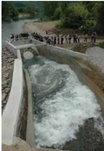
Remplissage du bief amont
