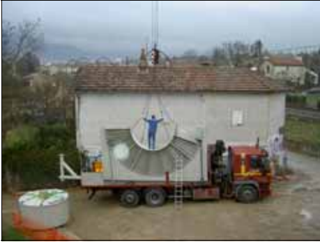
Livraison des 2 demi distributeurs et du générateur
