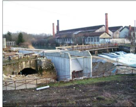
Centrale de Clairvaux
