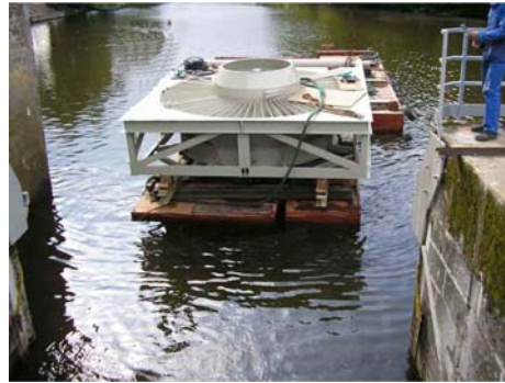
La barge entre dans l'emplacement
