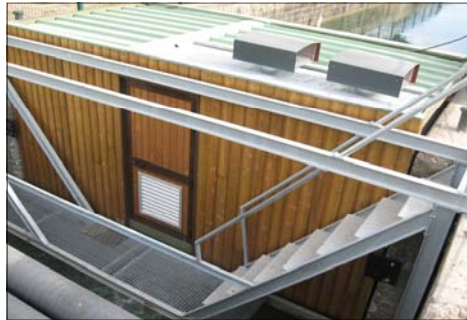
Vue arrière du local technique et de la passerelle d'accès
