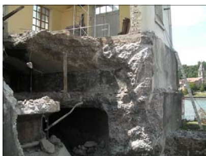
Démolitions à l'aval du bâtiment
