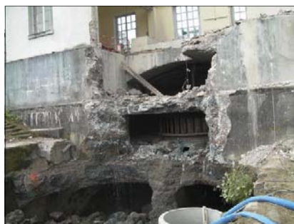
Démolitions à l'aval du bâtiment
