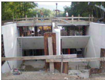
Amont de l'implantation des deux VLH
