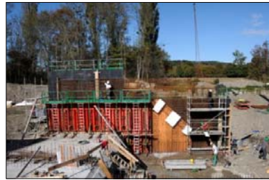
Chantier centrale les Barrets
