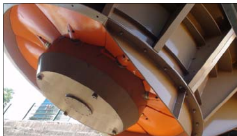
VLH de Huningue écluse n° 2 en position relevée vue de dessous
