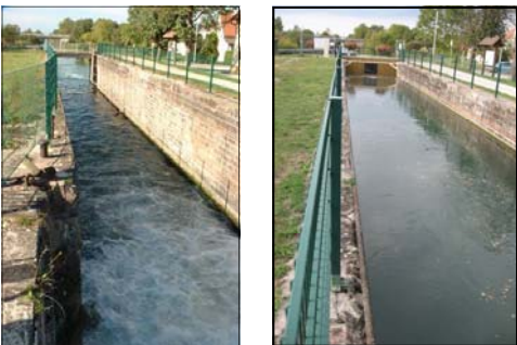
Avant et après installation de la VLH
