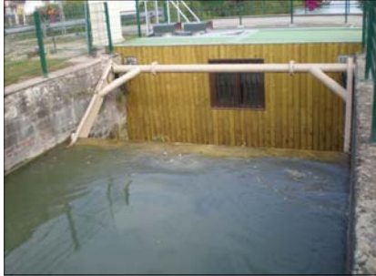
Écluse n°3 VLH et local technique
