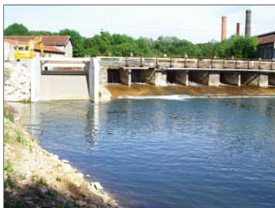
Centrale Hydroélectrique de Clairvaux
