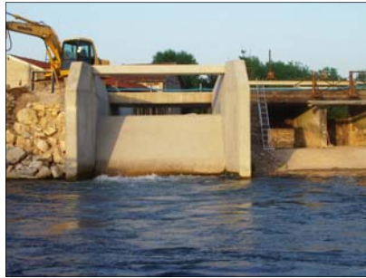
Vue Aval de la centrale de La Clairvaux
