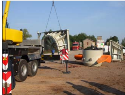
Déchargement d'une roue et d'un demi distributeur
