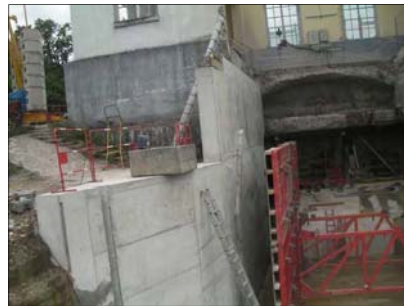
Décoffrage du bajoyer droit
