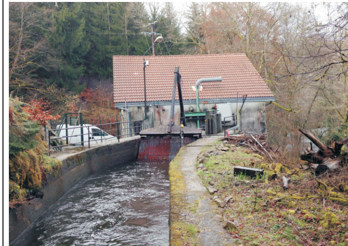
La centrale hydroélectrique
