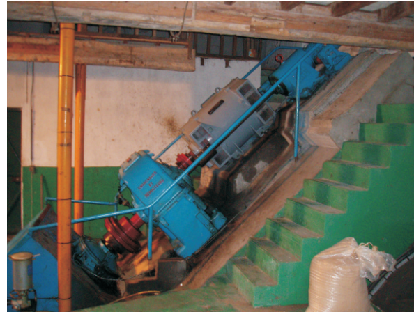
Installation avant rénovation
